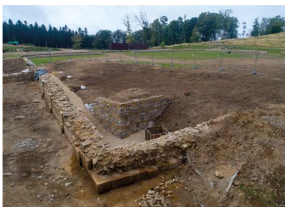
Exposition in situ des deux états de construction du mur de soutènement de la terrasse supportant le bâtiment public. En haut, vue du site en fin de fouille (2018) ; en bas, vue du site avec mise en valeur de l'angle de la terrasse (2022). Mur romain consolidé au premier plan, mur gaulois reconstitué au second plan. © BibRACTE, Antoine Maillier et Arnaud Meunier
